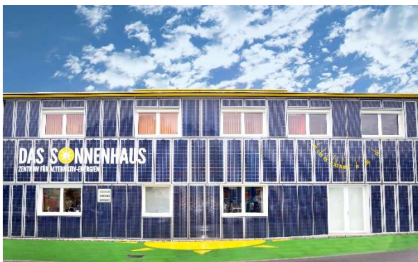
© Stadtwerke Kapfenberg GmbH
