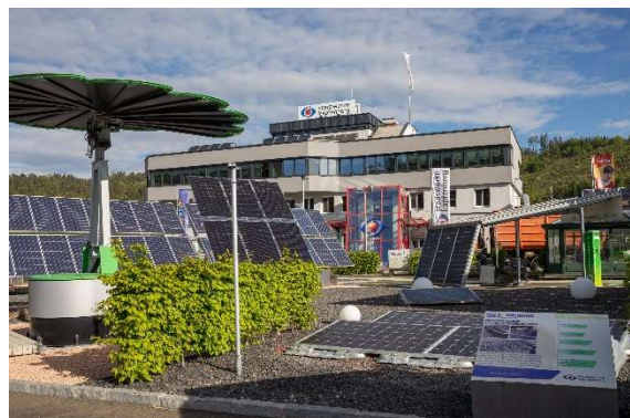
© Stadtwerke Kapfenberg GmbH
